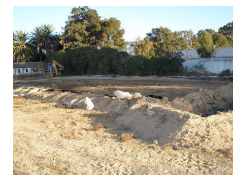
Detalle de foso para recogida de lixiviados
