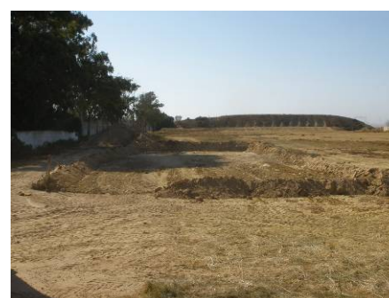
Preparación de la zona de tratamiento
