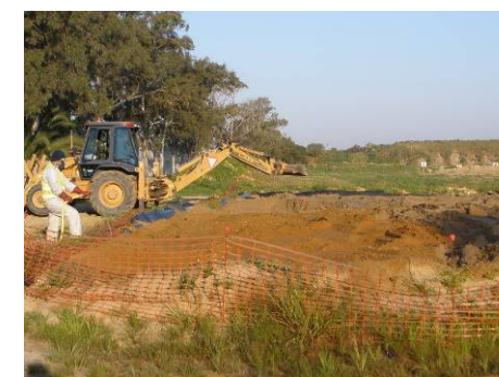
aplicación de agentes oxidantes y volteo del material tratado
