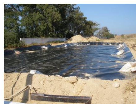
Impermeabilización de la base de la zona de tratamiento
