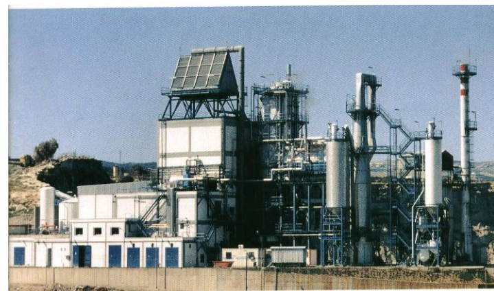
Detalle de la Planta Integral Incineradora de Residuos
