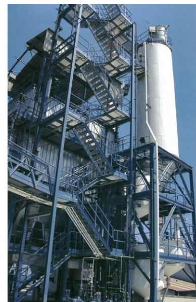
Detalle de la chimenea de la Planta
