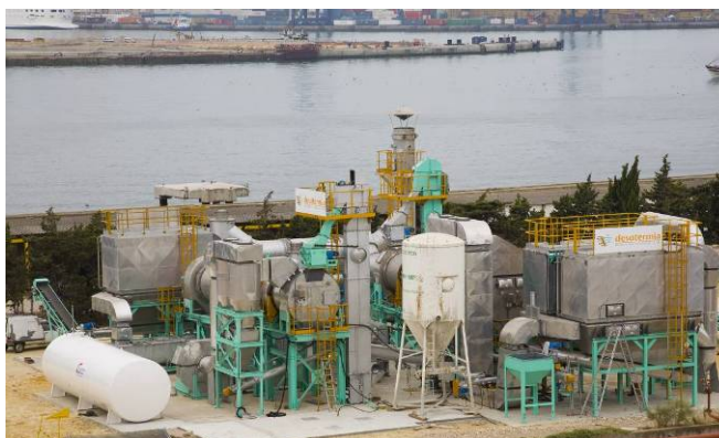
Vista general de las instalaciones
